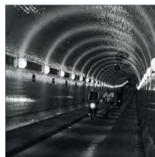
S-HH15 Alter Elbtunnel
