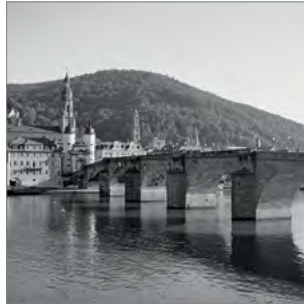
S-HD02 Alte Brücke
