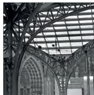
S-K11 Hauptbahnhof II
